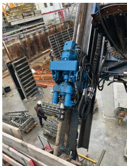
VD 150: Ziehen von Selbstbohrankern, 60 m lang
