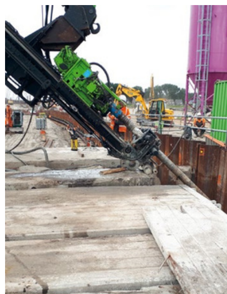
VD 150 bohrt 177,8 mm Außenrohre für 60 m lange Litzenanker
