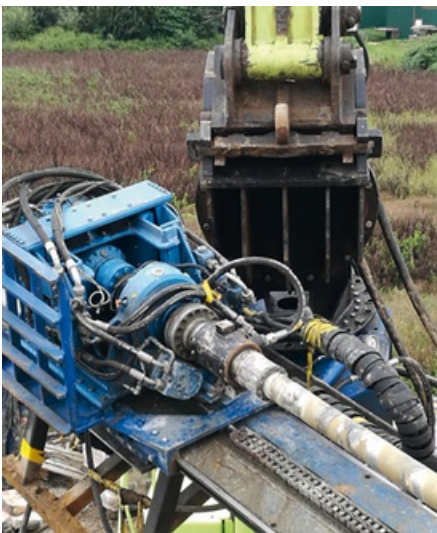
Bohren von 178 mm Rohren in 48 m Tiefe mit verlorener Bohrkronen
