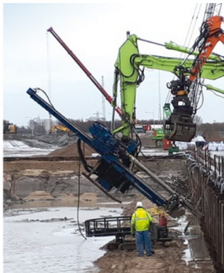
Bohren von 178 mm Rohren und 60 m tief in Sand und Kies
